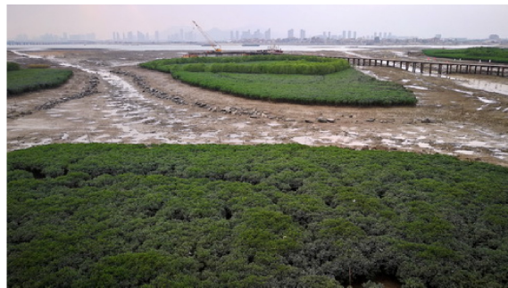
图2 2017年在建中的厦门下潭尾滨海湿地公园
